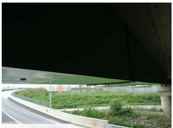
거더외부 S3 상태양호
