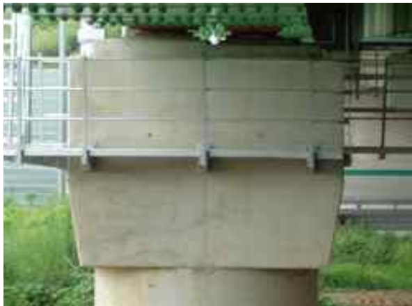
교각 P3 코핑부 상태양호
