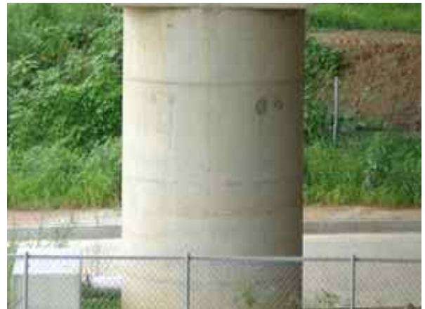
교각 P3 기둥부 상태양호
