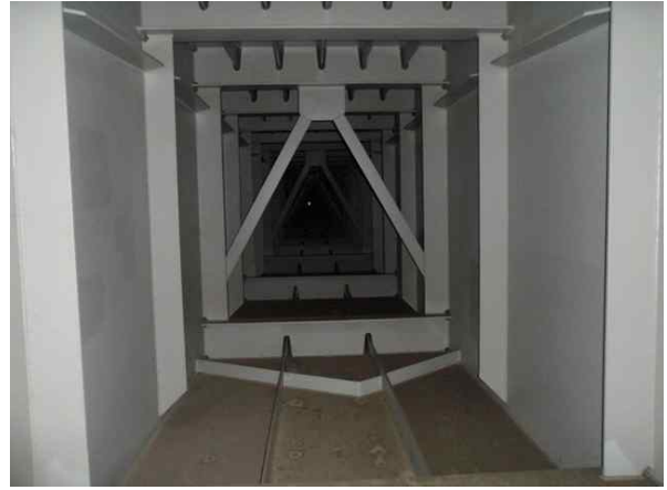
거더내부 S4 상태양호
