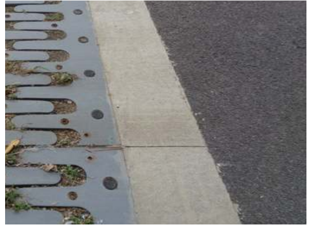
신축이음 A1 후타재 상태양호
