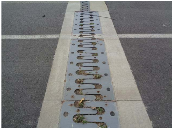
신축이음 A2 본체 상태양호
