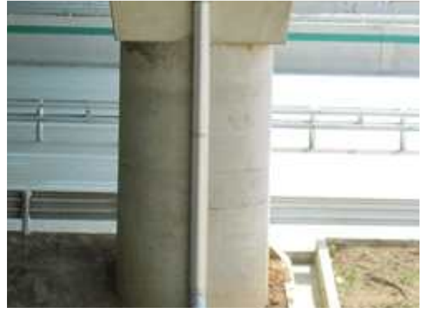
교각 P1 기둥부 상태양호
