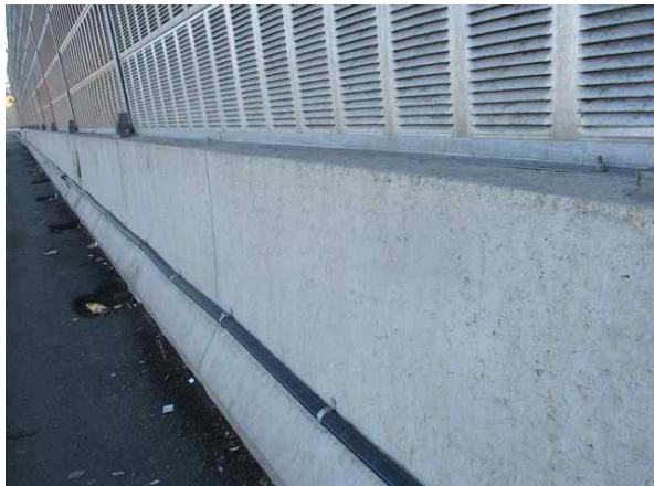
방호벽 S2 상태양호
