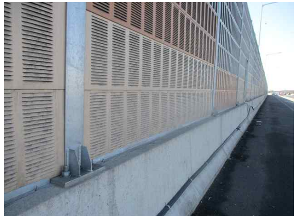
방호벽 S3 상태양호
