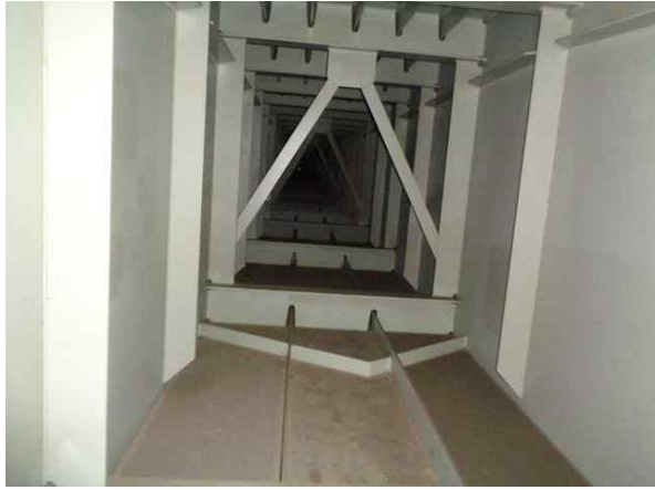
거더내부 S1 상태양호
