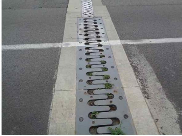
신축이음 A1 본체 상태양호
