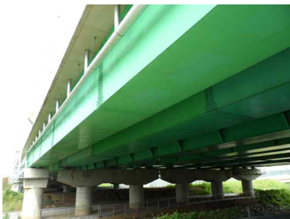
거더외부 S4 상태양호
