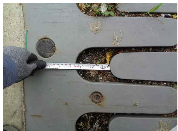
신축이음 이동량 측정
